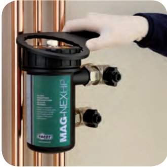
Fig. 4 - Utilizzo della chiave a ghiera in plastica
